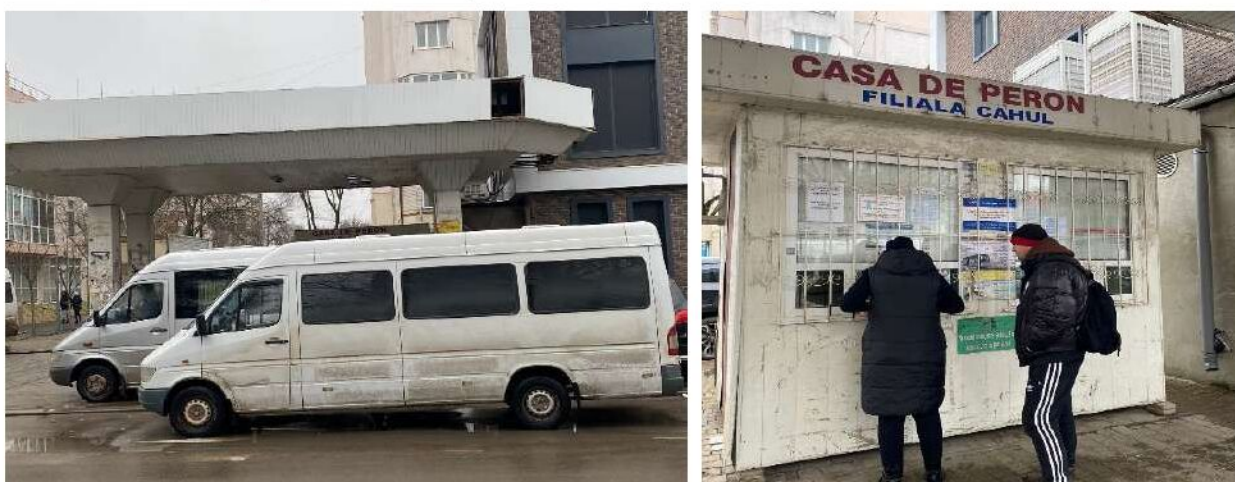
FIGURA 29. AUTOGARA (PUNCT DE OPRIRE) CENTRALĂ CAHUL
