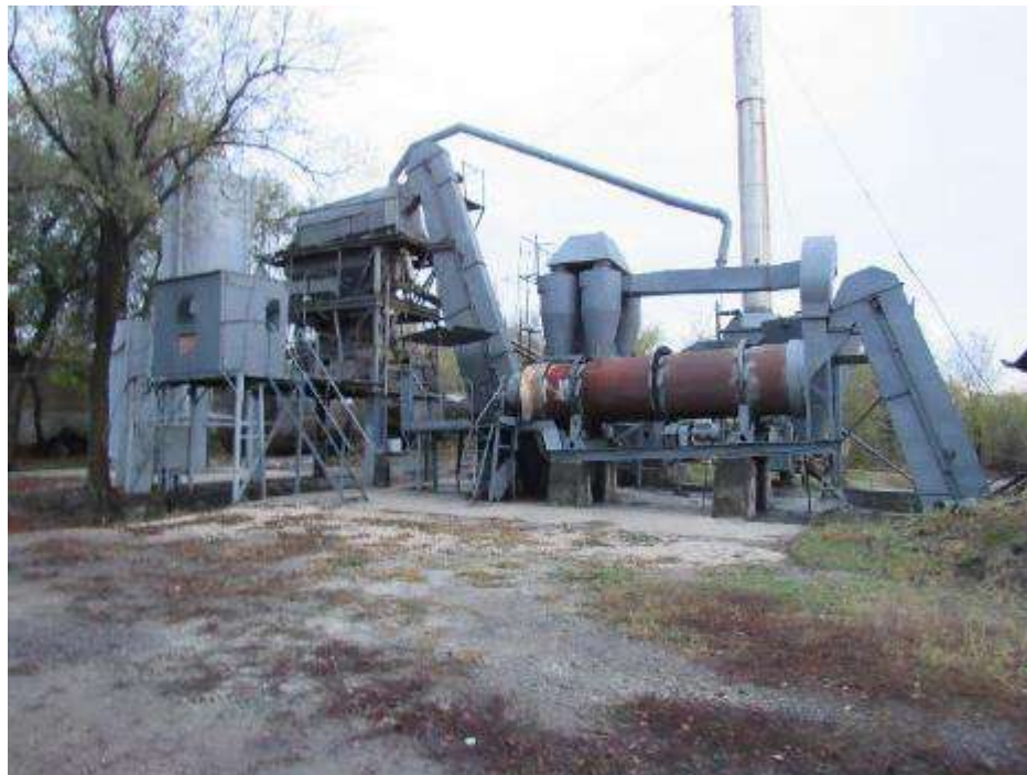
Figura 17 Fabrica de asfalt a IM Construcții și Reparație a Drumurilor și Spațiului Locativ Cahul
