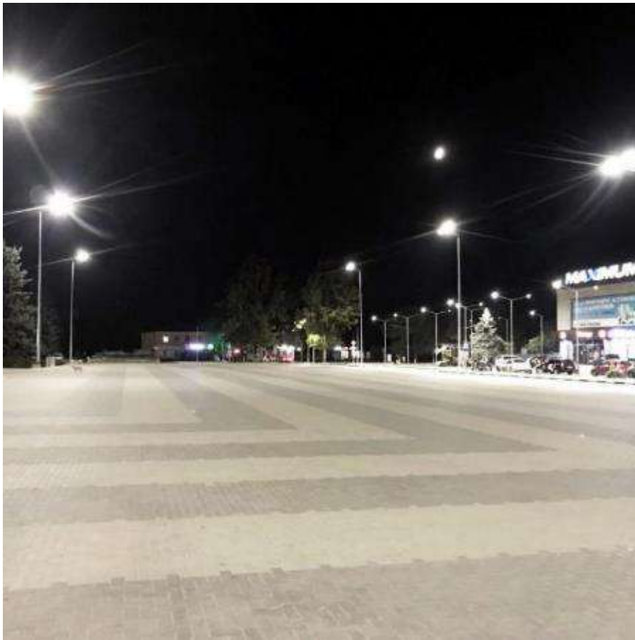
Fig. 13 Iliminatul public în Cahul
